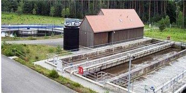
Der Zulauf in die erste Kammer wird mit dem Rücklaufschlamm vermischt unter einer tief gezogenen Tauchwand eingeleitet. In die zweite Kammer wird nitrathaltiges Kreislaufwasser aus dem Belebungsbeckenablauf zur Denitrifikation zurückgeführt. Zur Unterstützung der biologischen Phosphorreduzierung besteht zudem die Möglichkeit eines internen Teilkreislaufes aus dem Ablauf der zweiten in den Zulauf der ersten Kammer.
